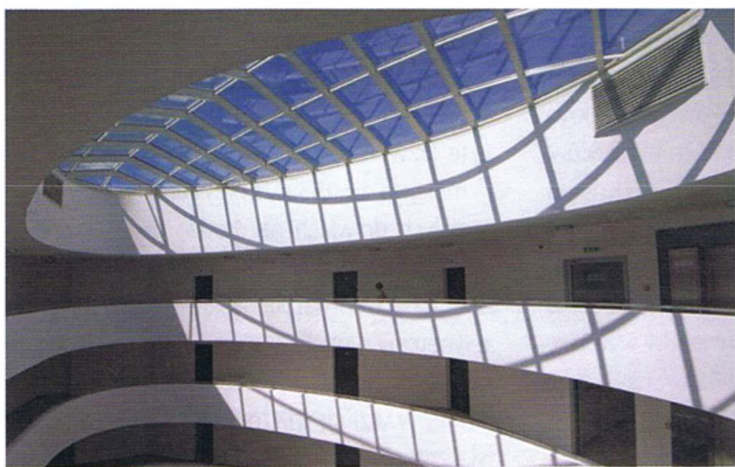
6. Dym jest wyciągany za pomocą wentylatorów oddymiających zlokalizowanych pod stopem atrium
