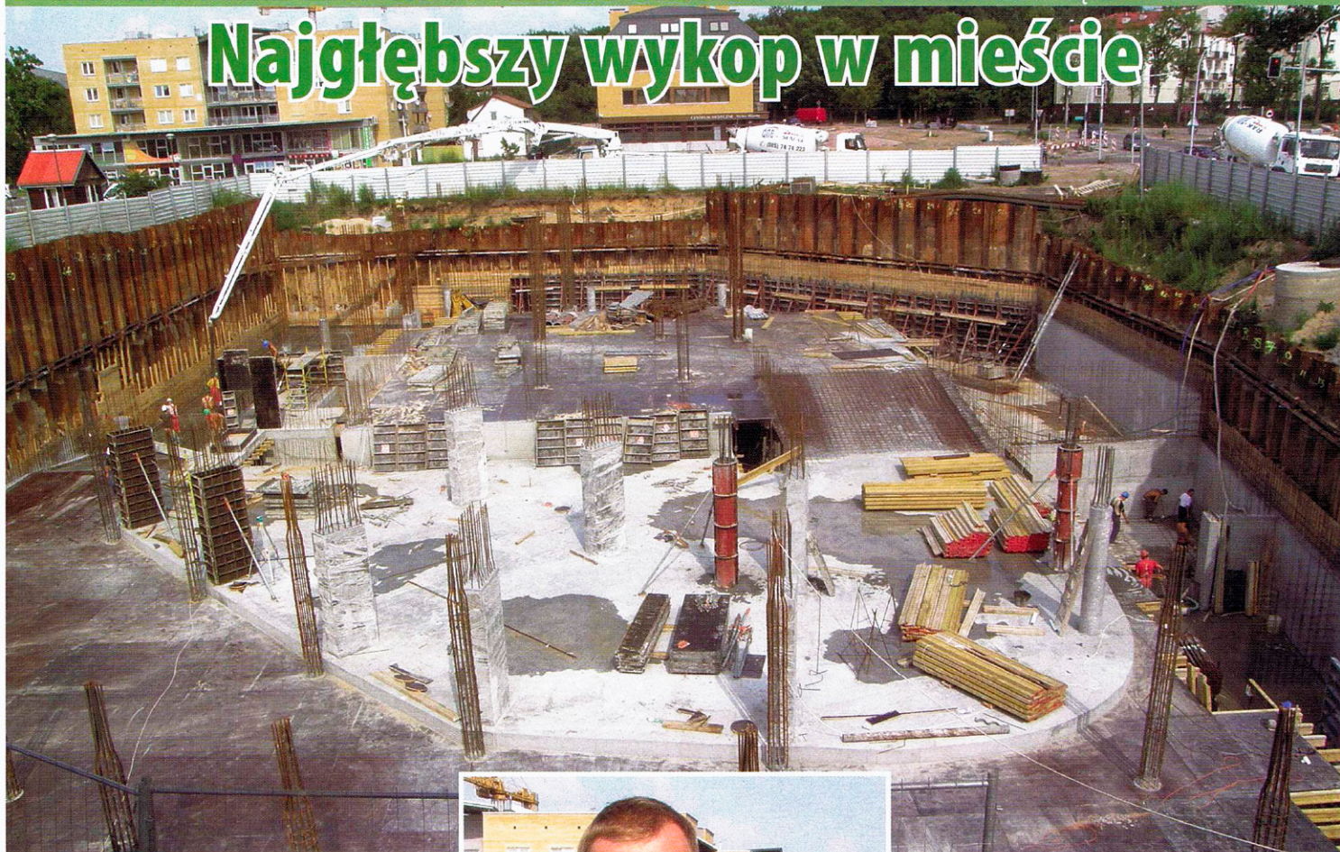
Widok na wakacyjny plac budowy
